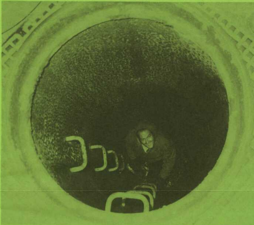
Andre Müller bei der Arbeit im Kanal
